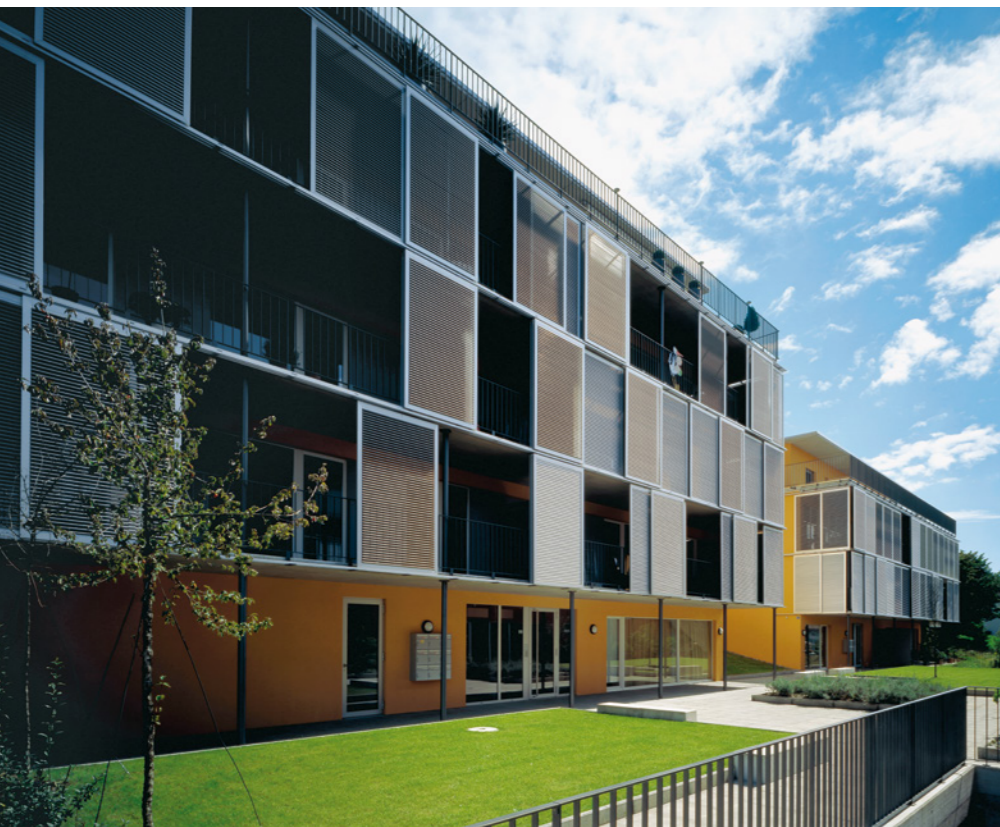
Volets coulissants : esthétiques et pratiques.
