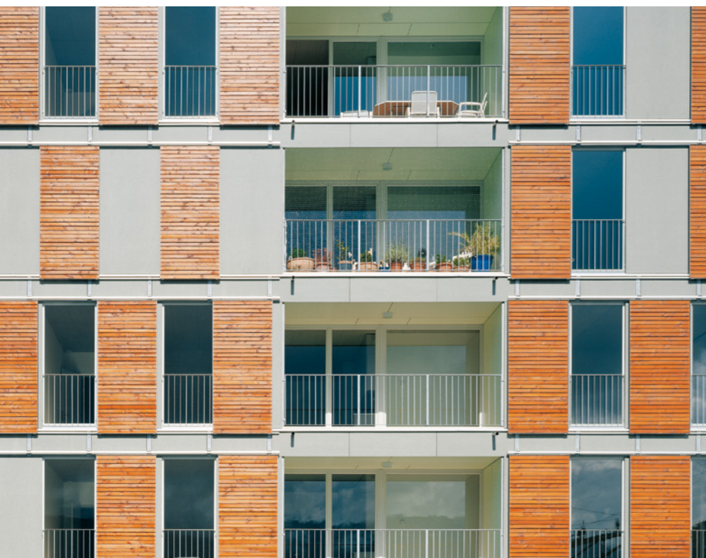
Protection variable contre la vue et le soleil pour l'aménagement de grandes façades.
