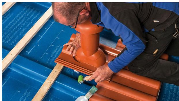
**10b. Bei flachgeneigten Dächern: Anschluss Rohrdurchdringungen**
