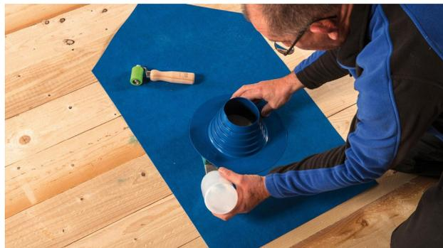
**10d. Bei flachgeneigten Dächern: Anschluss Rohrdurchdringungen**
