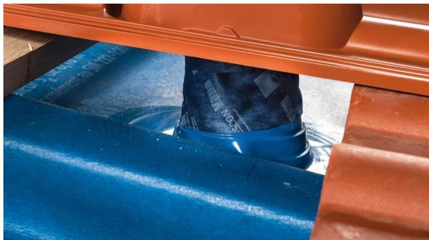
**10c. Bei flachgeneigten Dächern: Anschluss Rohrdurchdringungen**
