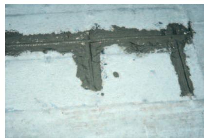
Per garantire una copertura completa dell'armatura, è anche possibile applicare PCI Nanocrete AP sul sottofondo adiacente
