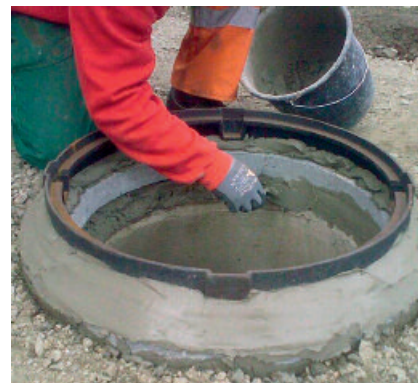
Les regards peuvent être posés rapidement avec PCI Polyfix plus.
