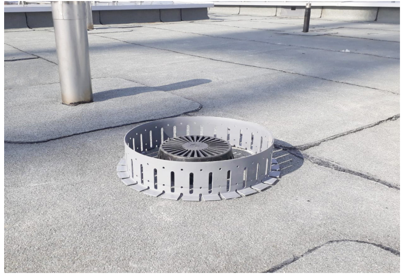
Der Kiesring aus robustem PVC hält den Dachkies effizient zurück.
