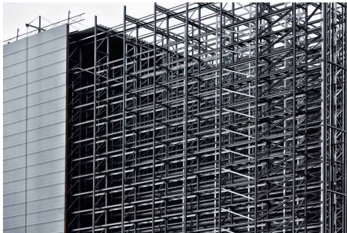
Construction de rayonnages hauts
