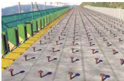
Réhabilitation de ponts
