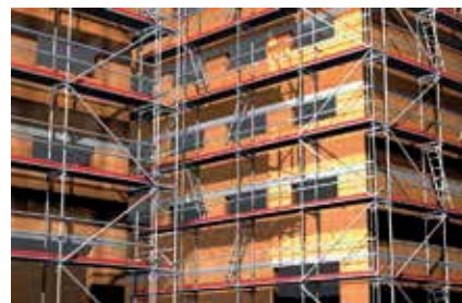
Echafaudages en façade
