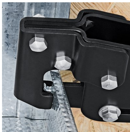
Posizionamento della punzonatrice su due profili di lamiera da unire
