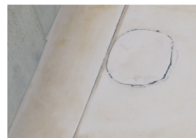
8 Die Flachdachreparatur ist abgeschlossen
