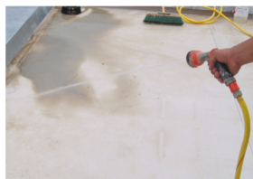
7 8. Abschlußarbeiten, Reinigen des Flachdaches
