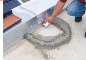
2 3. Leckstellenbereich mit einem Tuch o.ä. von der Restfeuchtigkeit befreien
