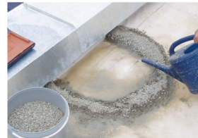
5 6. Dichtigkeitsprüfung der behandelten Reparaturstelle
