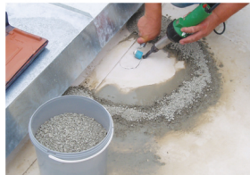
4 5. Nun kann die trockene Reparaturstelle bearbeitet werden
