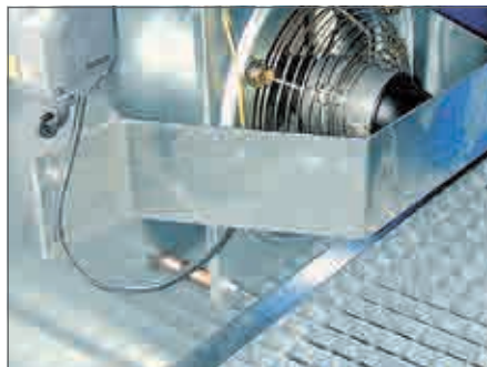
technische Zwangsentlüftung, ex-geschützt
