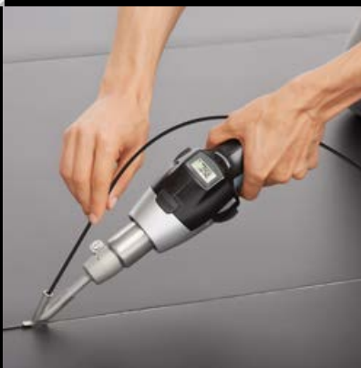
▼ Linoleumboden verschweißen HG 2620 E
