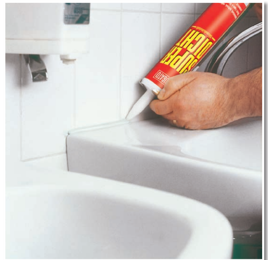
Fuge am Waschbecken dauerelastisch abdichten.
