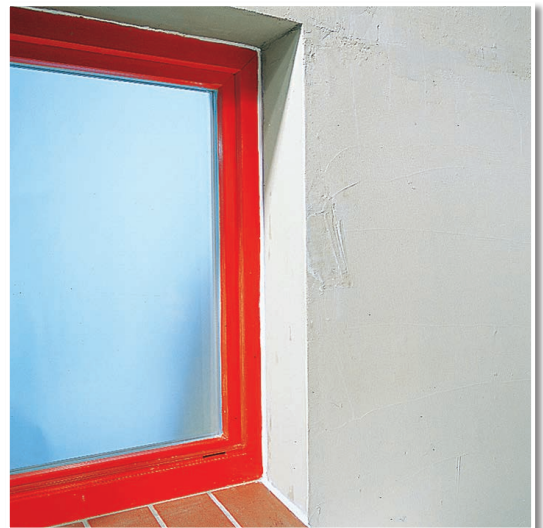
Verschluss der Anschlussfugen zwischen Fenster und Mauerwerk.
